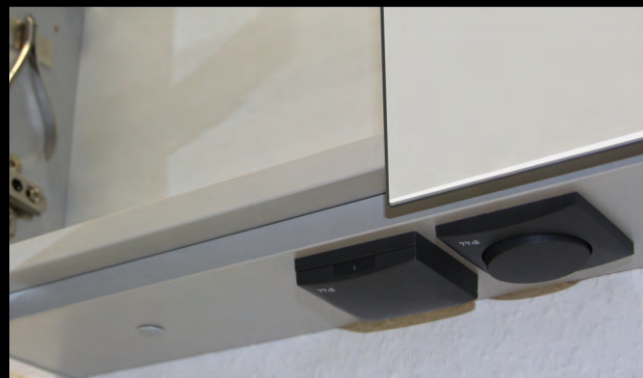
Detail umiestnenia el. zásuvky a vypínača BERKER zospodu korpusu zrkadlových skriniek: NY ZS, E ZS a D ZS
